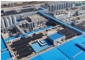
충주2공장 태양광 설치 모습
