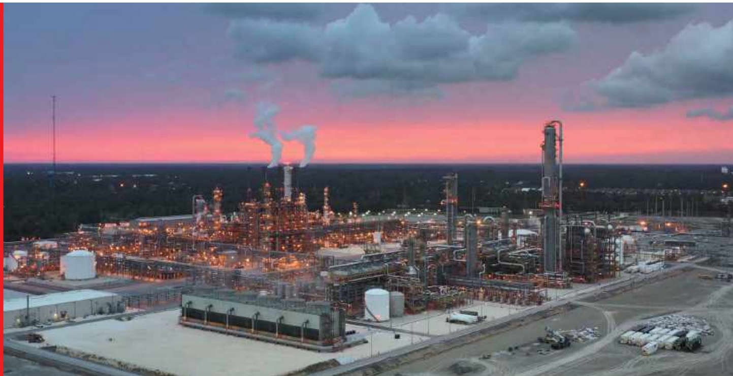
미국 롯데케미칼 USA 공장 전경
