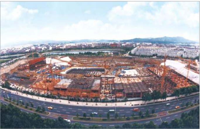
롯데월드 콘크리트 타설 전경
